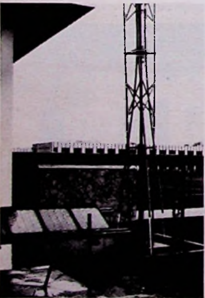
Afb. 4 Links op de voorgrond panelen met zonnecellen die energie leveren om de waterpomp aan te drijven.
